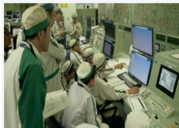
ガラス固化技術開発施設の制御室の様子
