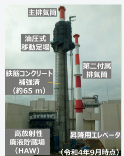
安全対策工事（主排気筒の耐震補強）
