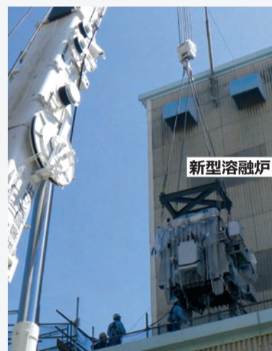
新型溶融炉の搬入作業（モックアップ試験棟へ）
