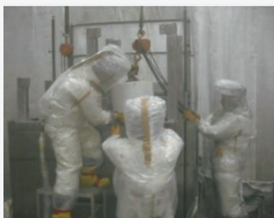
エアラインスーツによる解体作業
